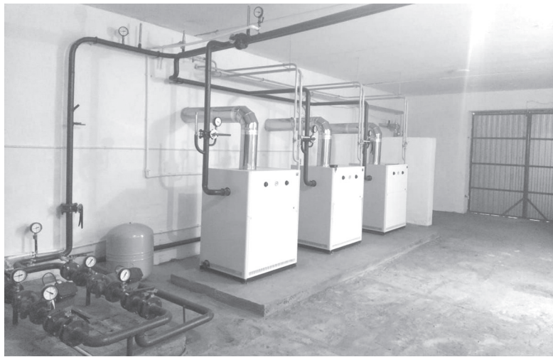
Установлено современное газоиспользующее оборудование в котельной Киселевского СДК
