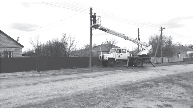
Установка уличного освещения
