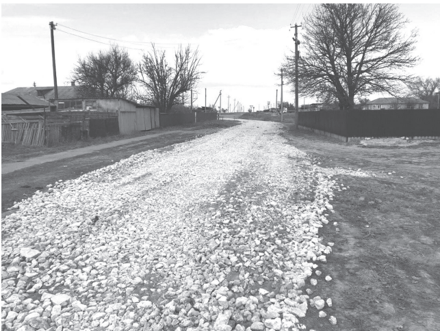
Проведена отсыпка дороги щебнем
